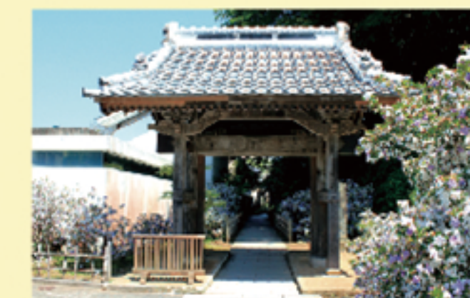
補修された山門
